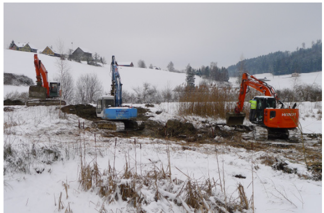
Das Aushubmaterial wird von Bagger zu Bagger geworfen
