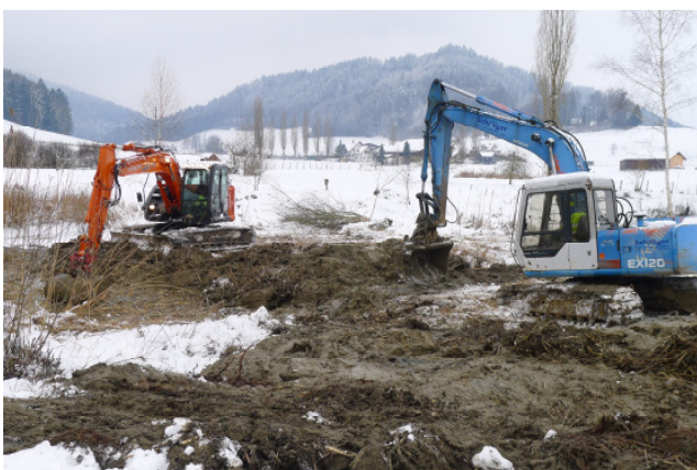
Aushubmaterial aus Seekreide und Schilf
