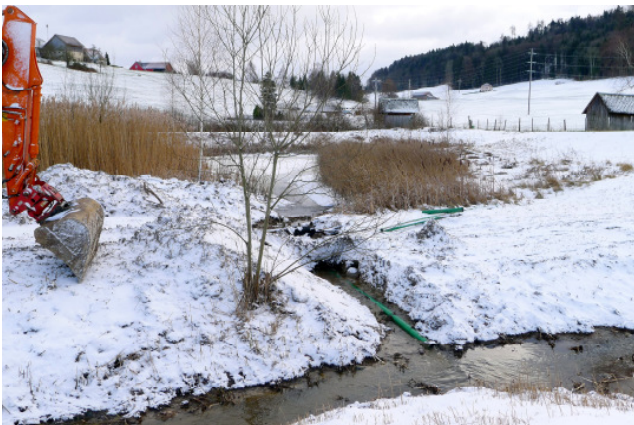
Absenkung des Wasserspiegels um 80 cm am 13. Januar 2017
